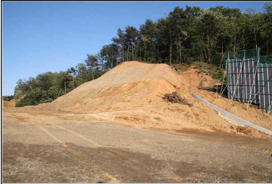
【그림 3】 깎기비탈면 시점부 측면 사진
