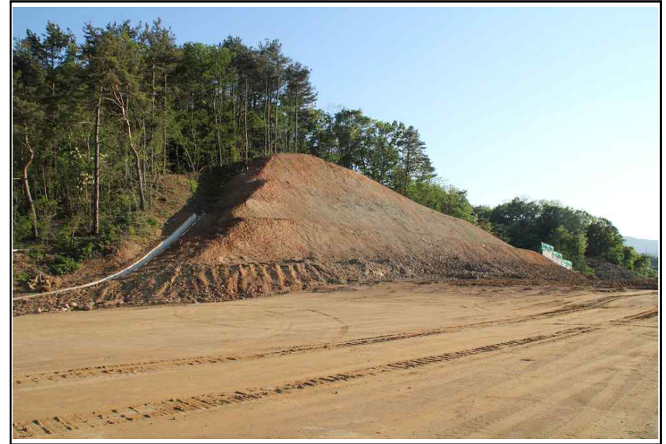
【그림 4】 깎기비탈면 종점부 측면 사진
