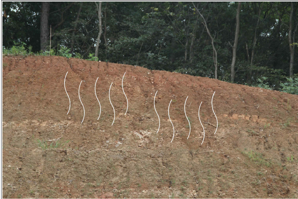
【그림 18】 A 영역 상세사진 (토사유실 및 우류침식)
